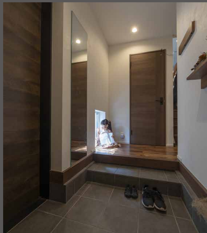
← 玄関に明かり取りとして低めのFIX窓を配置。框の中間に段差を設けたことで、子どもでも楽に靴の脱ぎ履きができる。将来的にも、バリアフリーな設計。
